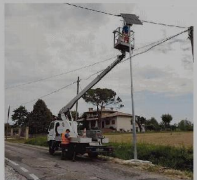
L'installazione dei nuovi punti luce lungo le strade di Chions
